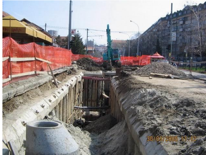
Slika Izgradnja kolektora Duboki potok u otvorenom iskopu
