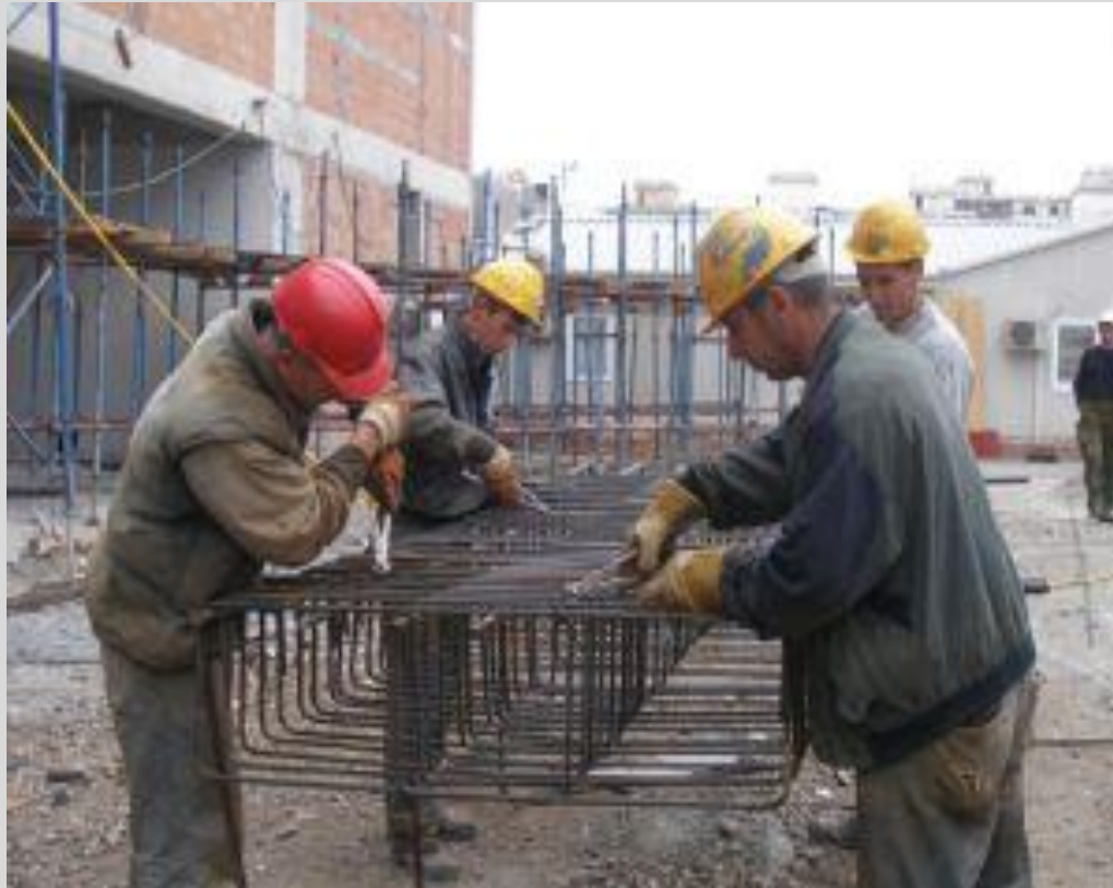
Слика 5 : Армирачи - обавезно је коришћење армирачких рукавица и шлема
