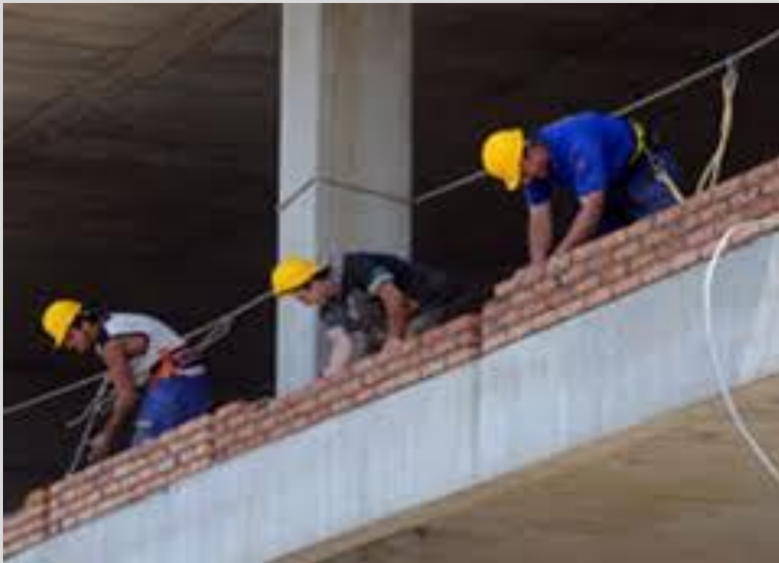
Рад на висини – зидање фасадних зидова
